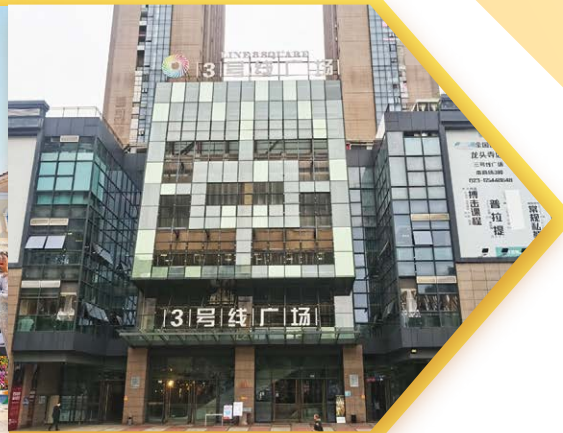
重慶三號線廣場
